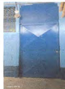
Foto 2: mantenimiento de estructura (lijado, cambio de tubo,sugeciones,aplicación de pintura) 5 puertas en aulas y 3 en servicios sanitarios
