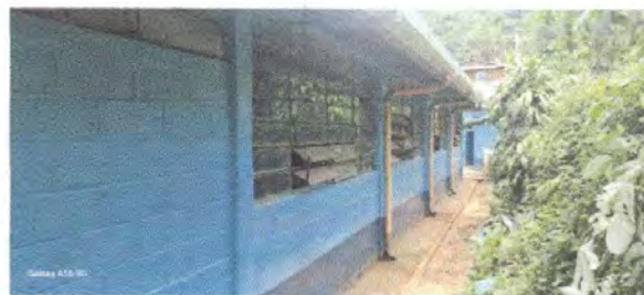
Foto 4: Fabricación e intalacion de balcones de hierro en ventana.
