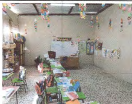
Foto 8: Repello de muro
