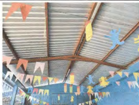
Foto 7: Sustitución de focos ahorradores. Sustitución de plafoneras. Sustitución de interruptores dobles. Sustitución de toma corrientes dobles. Sustitución de cableado eléctrico. Sustitución de ducto eléctrico +
