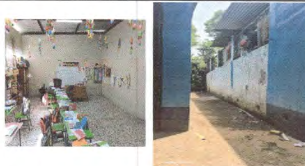
Foto: 10 Pintura en Muros Exteriores e Interiores
